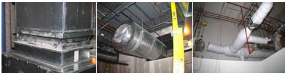
Резиновые подушки, воздуховоды с двойными стенками и изоляцией – меры против шумов и вибраций (иллюстрация ORNL).
